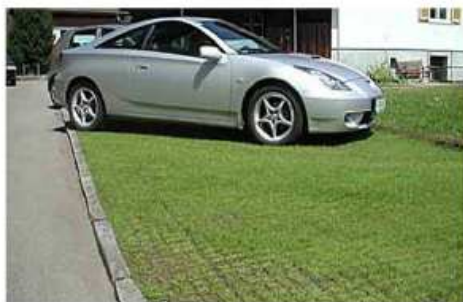
Réalisation des parkings à l'intérieur des lots en dalles gazon, qui seront traitées en voirie lourde
